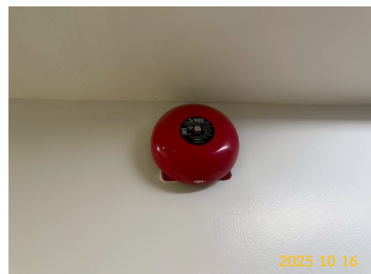
ภาพที่ 2.2-47 สัญญาณแจ้งเหตุเพลิงไหม้
