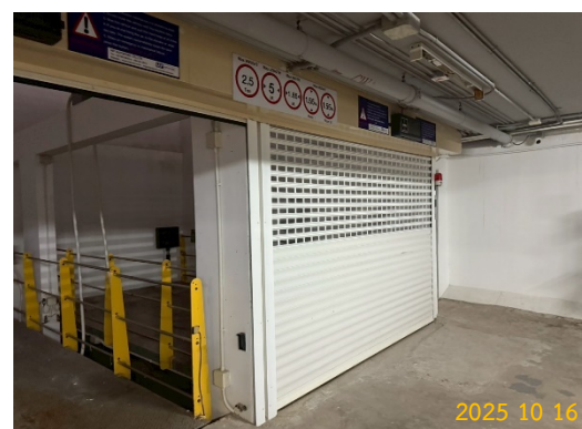
ภาพที่ 2.2-25 ระบบยกถขึ้น-ลงระหว่างชั้นของอาคาร ด้วยลิฟต์
